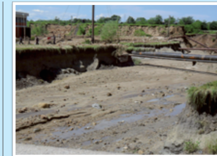
Слика 1. Место пробоја бране Кладница у зони челичних потисних цевовода
